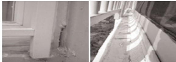
▶ 발코니 상부 및 측부누수(누수유형의 35% 차지) ▶ 페인트 박리 및 우레탄 실란트 균열, 저급 실란트 파열
