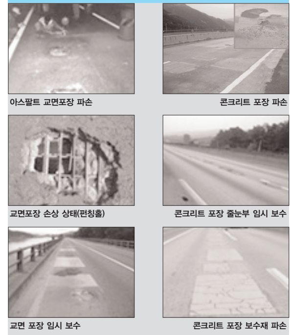
■ 그림 1. 콘크리트 포장 및 교면포장의 파손유형
