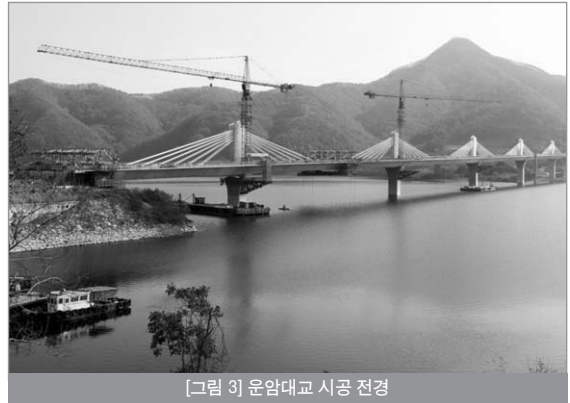
[그림 3] 운암대교 시공 전경
