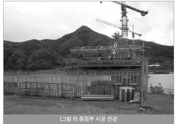
[그림 5] 중점부 시공 전경
