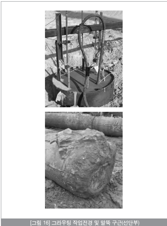
[그림 16] 그라우팅 작업전경 및 말뚝 구근(선단부)
