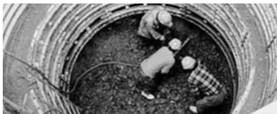
4. 천공 및 Liner Plate 설치
