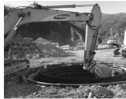
7. Liner Plate 고정
