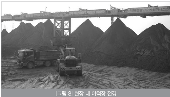
[그림 8] 현장 내 야적장 전경
