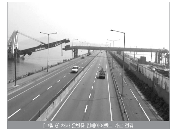
[그림 6] 해사 운반용 컨베이어벨트 가교 전경
