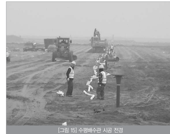
[그림 15] 수평배수관 시공 전경
