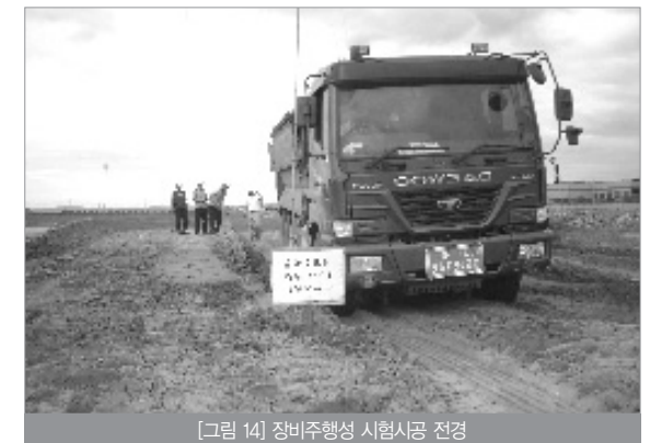
[그림 14] 장비주행성 시험시공 전경
