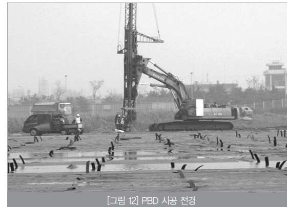
[그림 12] PBD 시공 전경
