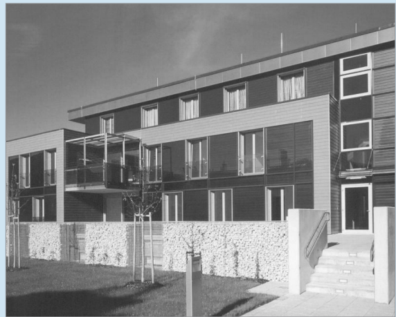
[그림 9] 95m 2 파사드일체형 BIST / 25m 2 지붕설치형 PV, Salzburg, Austria, 2005. (Source : AKS DOMA)
