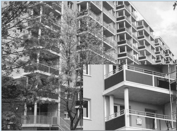
[그림 10] 295㎡ 발코니형 태양열급탕시스템, Leipzig, Germany, 2005., (Source : Schuco International KG)
