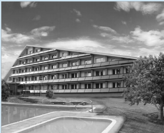
[그림 12] 236㎡ 발코니일체형 BIST, 호텔 태양열급탕 및 수영장난방, Hotel Jezerka, Czech Republic, 2007., (Source : IEA-SHC)
