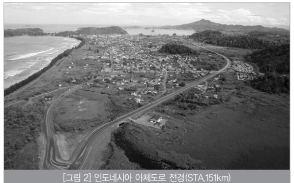
[그림 2] 인도네시아 아체도로 전경(STA.151km)
