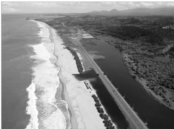
[그림 1] 인도네시아 아체도로 전경(STA.128km)
