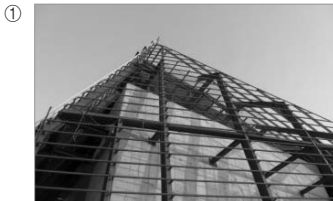
[그림 2] 외벽 마감공사 전경
