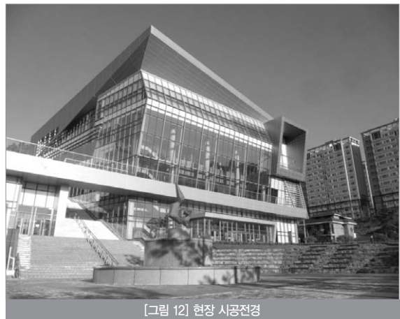
[그림 12] 현장 시공전경
