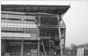
유리 및 커튼월 시공
