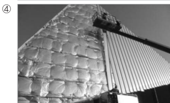
[그림 3] 지붕 판넬 시공단계별 전경
