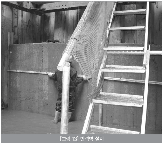
[그림 13] 반력벽 설치
