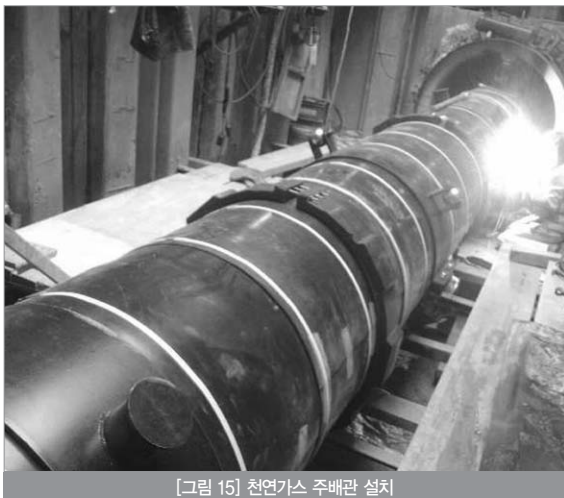
[그림 15] 천연가스 주배관 설치
