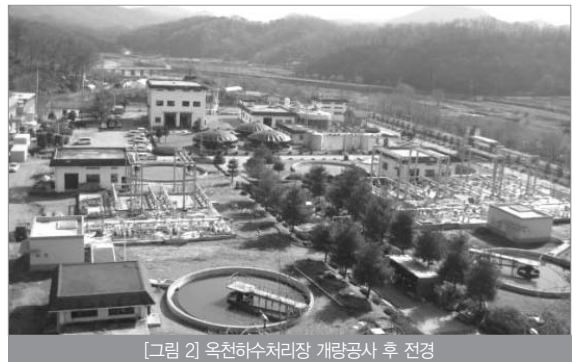
[그림 2] 옥천하수처리장 개량공사 후 전경
