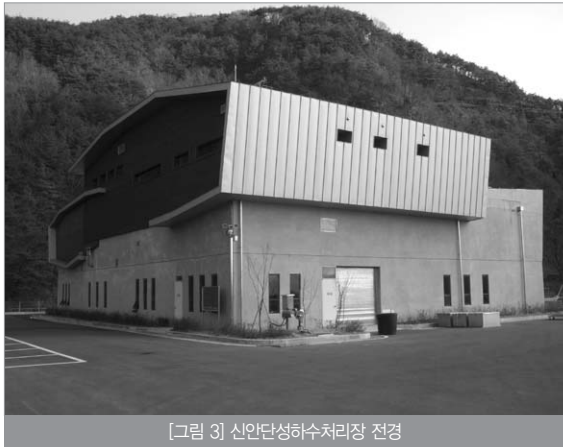
[그림 3] 신안단상하수처리장 전경
