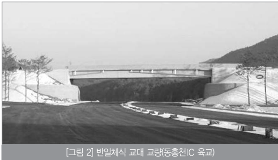
[그림 2] 반일체식 교대 교량(동흥천IC 육교)
