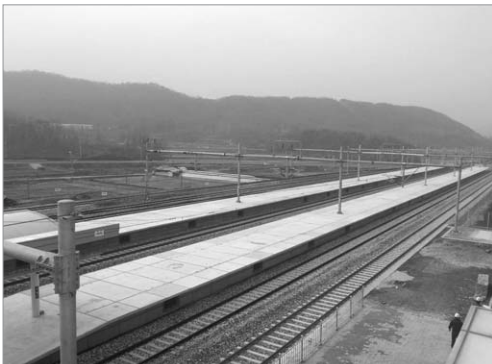
〈승강장 시공 완료〉
