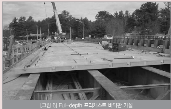
[그림 6] Full-depth 프리캐스트 바닥판 가설
