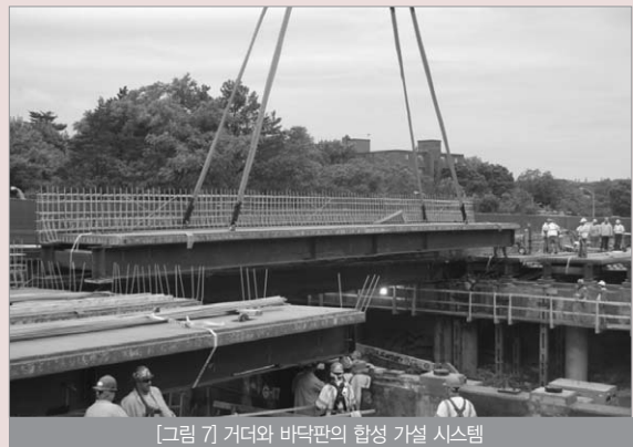
[그림 7] 거더와 바닥판의 합성 가설 시스템
