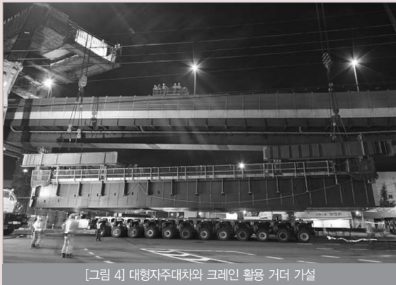
[그림 4] 대형자주대차와 크레인 활용 거더 가설
