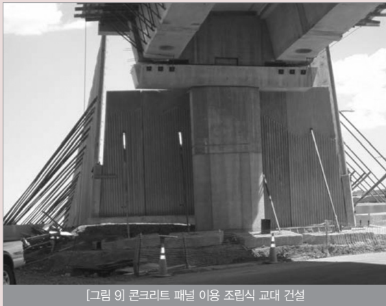
[그림 9] 콘크리트 패널 이용 조립식 교대 건설
