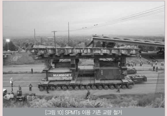
[그림 10] SPMTs 이용 기존 교량 철거
