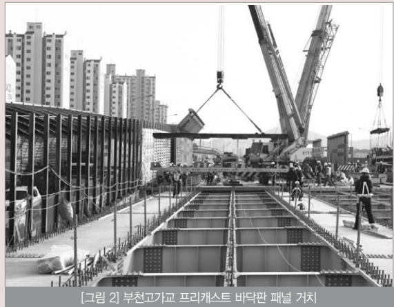
[그림 2] 부천고가교 프리캐스트 바닥판 패널 거치
