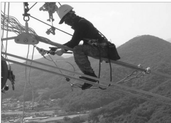
⑤ 현수클램프가 전선 위치에 오도록 애자장치를 내린 후, 전력선을 현수클램프에 취부한다.
