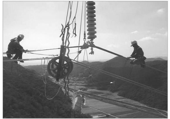
⑥ 현수클램프에 전력선의 중심이 안착되면, 아마로드의 나머지 부분을 시공한다.
