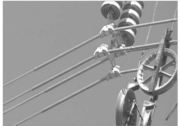
⑦ 현수클램프에 전력선 설치작업이 끝나면 전선클램프를 풀어내고 일체형 후크와 기타 장비를 전력선에서 해체하여 철거한다.
