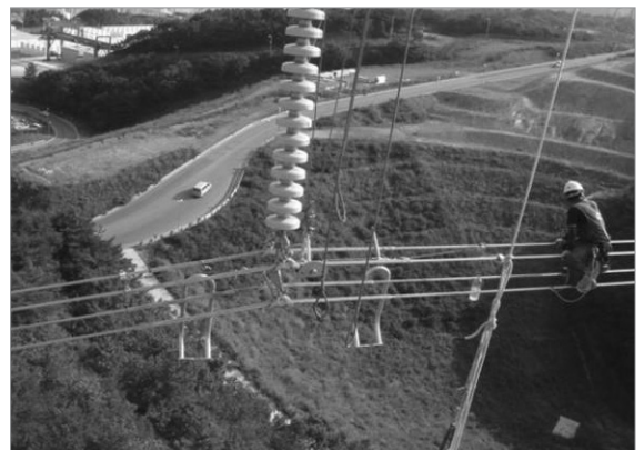
⑧ 애자장치에 전력선 취부작업이 종료되면, 요크에 아킹링을 설치하고, 현수형 철탑의 긴선작업을 마무리한다.
