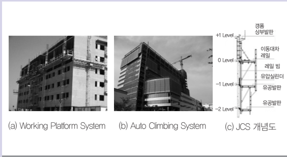
[그림 6] 외단열 시공을 위한 최근 가설공법(출처 : 구글 검색 및 콘솔SWC)
