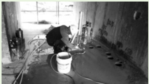
[그림 2] 내부 파이프덕트 설치를 위한 슬래브 코어링 공사현황
