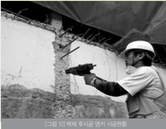
[그림 11] 수직부재(기둥 혹은 벽체)에서의 수직접합부 사례 (기존 벽체에 후시공 앵커 시공을 통한 전단접합 사례)
