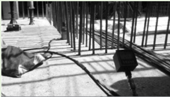
[그림 9] 기존 지붕층 상부 후시공 앵커 시공현황
