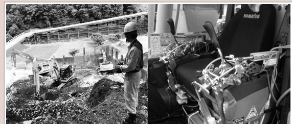
[그림 5] 오바야시 건설의 「범용 원격조종장치」 11)
