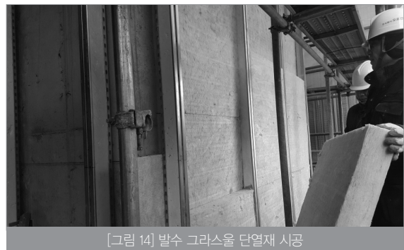
[그림 14] 발수 그라스울 단열재 시공
