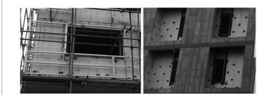
[그림 5] 단열재 본드 부착 후 트러스 하지 설치
